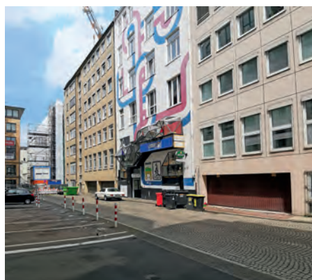
Vorher: Die Projektarbeit „da|zwischen“ hat u.a. die Herdentorswallstraße für eine Transformation ausgewählt.
